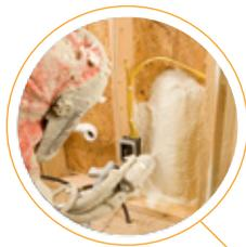
Dachdämmung mit geschlossenzelligem PUR-Ortspritzschaum
