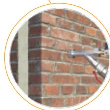
Hohlraumdämmung zwischen Mauerwerken PUR-Ortgießschaum
