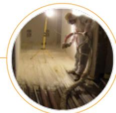
Fußbodendämmung mit geschlossenzelligem PUR-Ortspritzschaum
